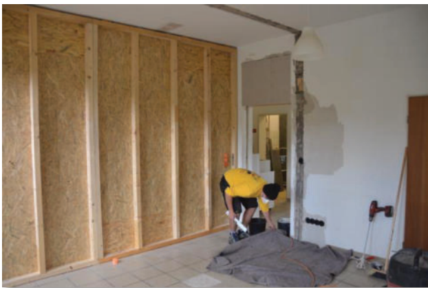
Die Rettungswache Hausach wurde nicht nur renoviert, sondern auch in weiten Teilen umgebaut.
