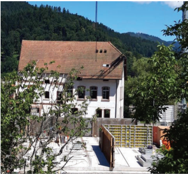
Das Fundament beim Neubau steht, die Aussichten werden beinahe täglich besser.
